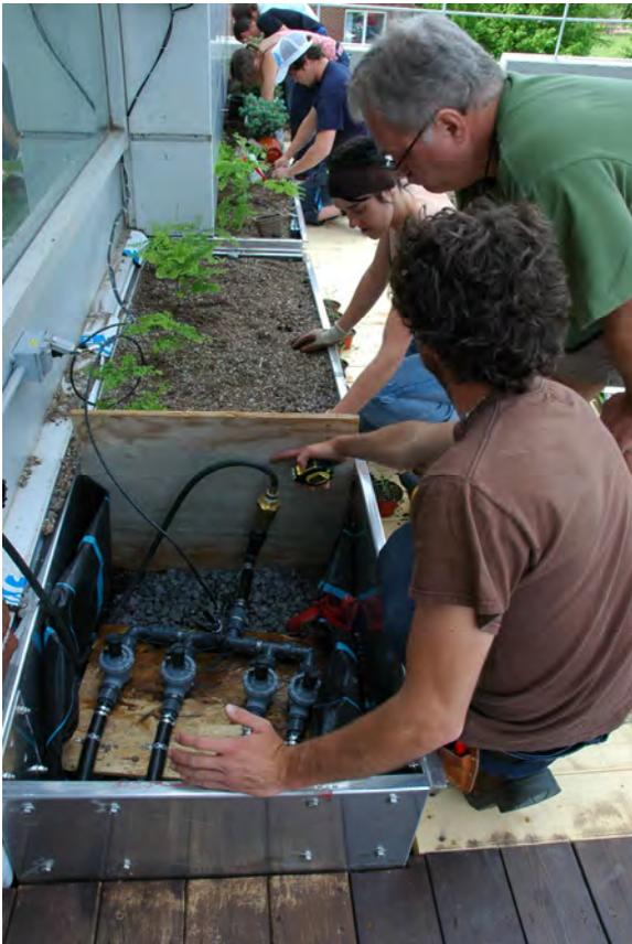
Photo 12 : Réseaux d'irrigation en 4 zones permettant d'alimenter des parcelles séparément.
