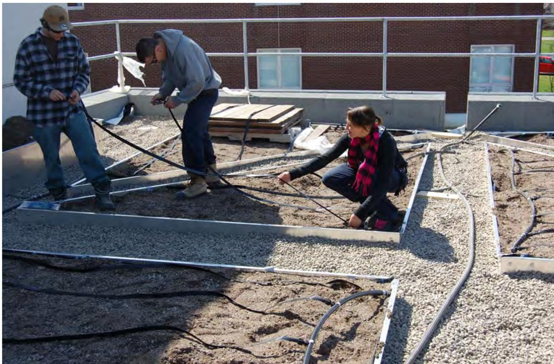
Photo 8 : Un système automatisé d'irrigation de type goutte à goutte était indispensable. Des tuyaux perforés insérés au sol ont été installés et répartis sous les surfaces de plantation.
