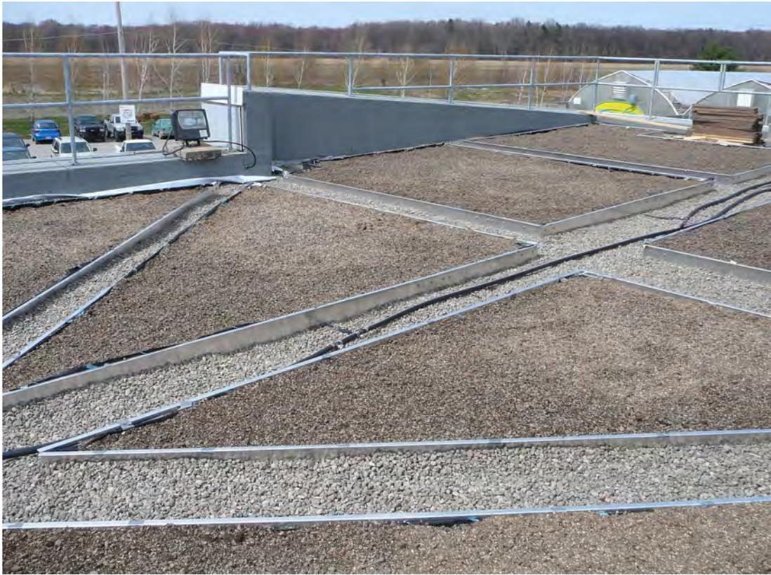
Photo 7 : Des sentiers faits de gravier recouverts de bois, encerclent les espaces de plantation. Ils permettent l'entretien de ces espaces et camouflent le système de distribution d'eau.
