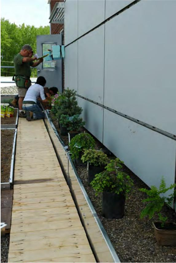
Photo 11 : Cette section comprend des plantes grimpantes et des conifères. Les grimpantes sur le mur extérieur permettent de jouer le même rôle d'isolation que sur le toit vert.
