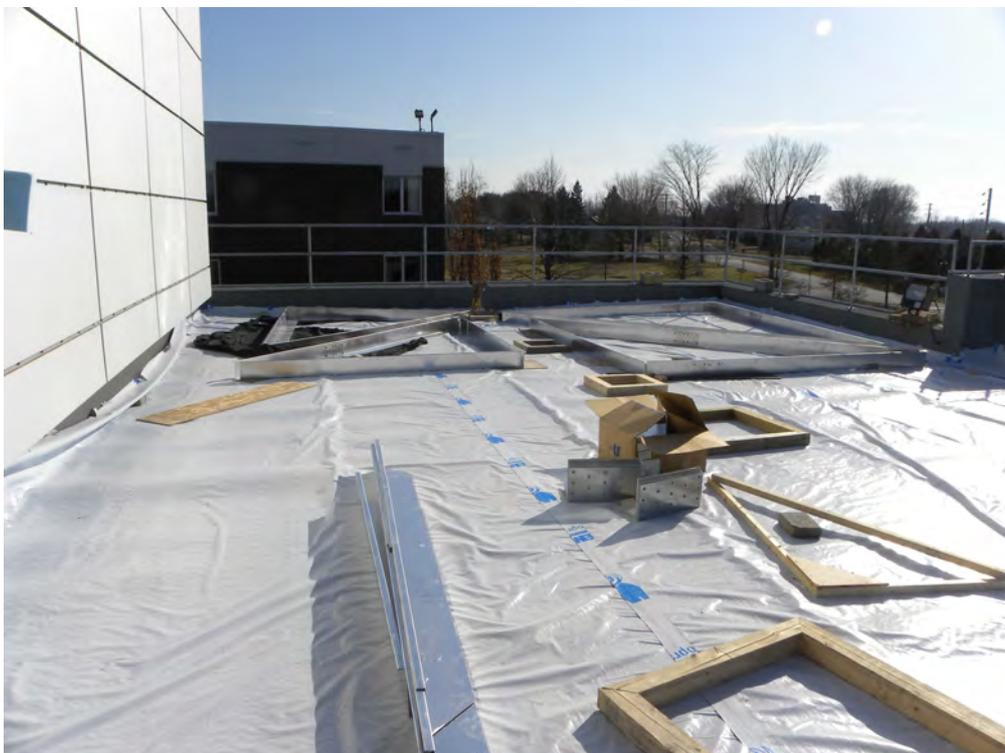
Photo 4 : À cette étape, les éléments suivants ont été installés : panneaux de drainage et membrane anti-racine. Les divisions en aluminium forment les parcelles qui contiendront le substrat. Elles ont été produites par une entreprise de la région de Nicolet.
