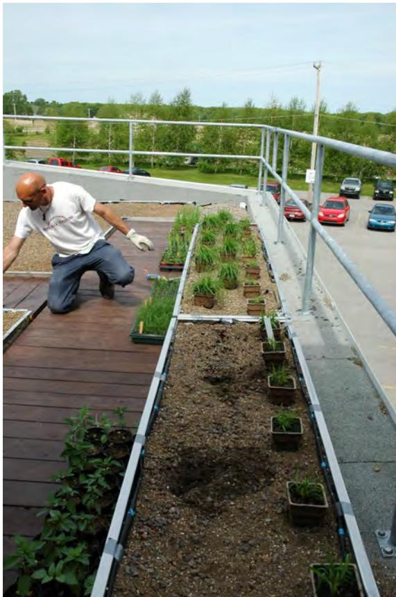
Photo 10 : Le Service des incendies de la ville de Nicolet a exigé qu'un espace soit disponible en permanence afin d'avoir accès au toit. Une trappe prévue sous le sentier de bois leur permettrait de percer le toit en cas de nécessité.
