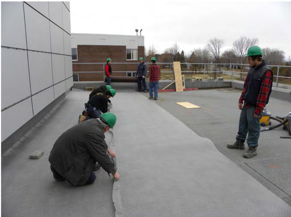
Photo 2 : Installation des membranes et panneaux de drainage, printemps 2010
