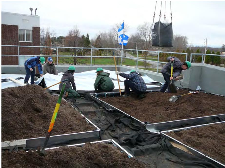
Photo 5 : Les bordures en aluminium retiennent le substrat (terreau calibré spécifiquement pour les toitures de type taïga)
